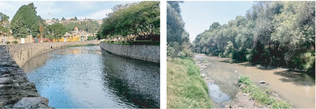
FIGURA 3. Río Zahuapan. Foto muestra la cobertura vegetal de río y la sección en donde se observa un muro que confina tras su paso en la Ciudad de Tlaxcala y las características naturales que prevalecen a pesar de la mala calidad que muestra el cauce principal. Foto: cortesía de Omar Arellano-Aguilar.
